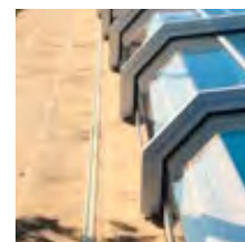
Rails de guidage
